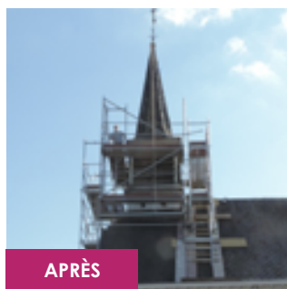
Redressement du clocher de la chapelle à Hèvermont
