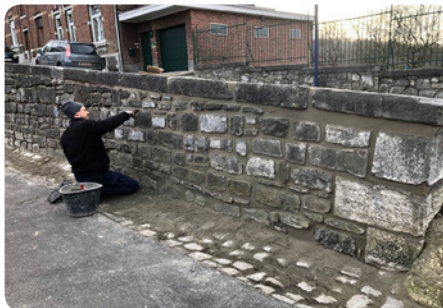
Rejointoyage du mur de soutènement du Thier de Limbourg
