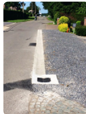
Pose de filets d'eau et d'un avaloir à Wooz
