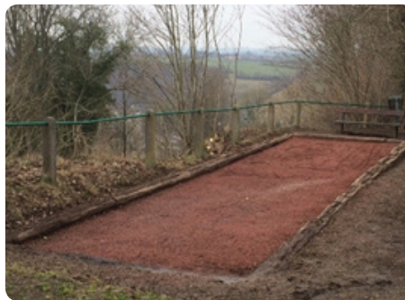
Réhabilitation du terrain de pétanque sur les Remparts.
